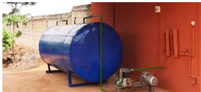
Tank à biogaz, groupe électrogène et interrupteurs
